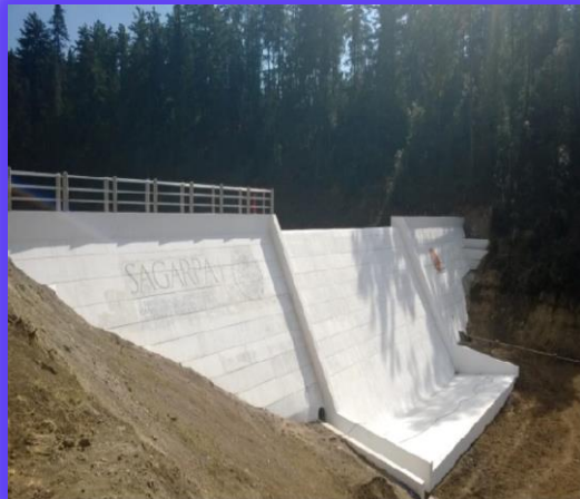
Obra concluida en Emiliano Zapata, Edo. de Tlaxcala.
